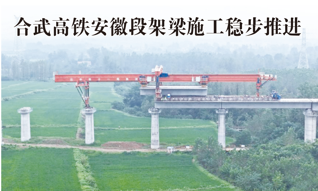
合武高铁安徽段架梁施工稳步推进 初秋，中铁十一局合武高铁安徽段站前三标箱梁架设、运输施工现场一派繁忙，建设者利用有利天气，稳步推进重点铁路工程建设。图为中铁十一局工人在合武高铁安徽段汲东特大桥箱梁架设现场作业（无人机照片）。 （彭特 / 摄）
