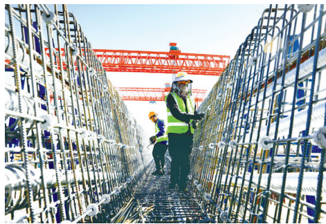
▲智慧梁场工人正在工作中。
