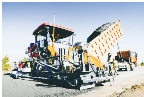
▲水稳底基层施工中。
